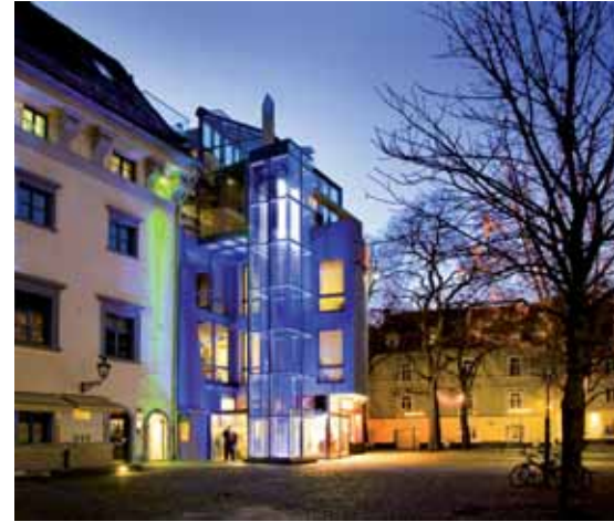
M1 Café - Bar in Graz mit ThyssenKrupp-Aufzug (Bild: ThyssenKrupp Elevator)
